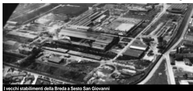
I vecchi stabilimenti della Breda a Sesto San Giovanni
