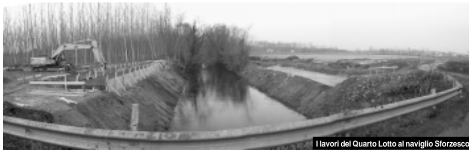
I lavori del Quarto Lotto al naviglio Storzese
