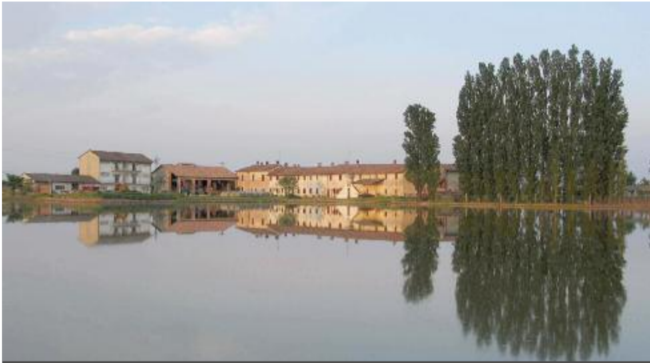
Cascina Frati a Valle Lomellina. Si tratta di un edificio antecedente al XV secolo a corte chiusa multipla con edifici aggiunti.
